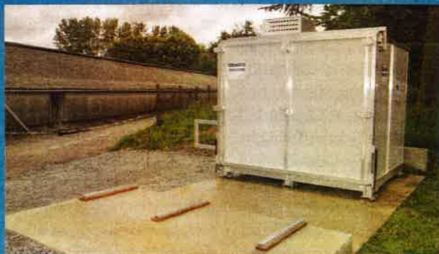
Le caisson frigorifique est équipé d'un échangeur à froid statique. Grâce au système de motorisation à crémaillère (type portail), le plateau coulisse le long de rails jusqu'à une plateforme extérieure. ©A. Puybasset
